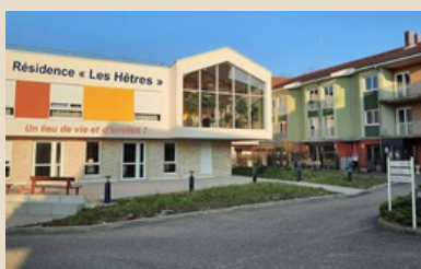
11 juin - Ehpads de Faulx
